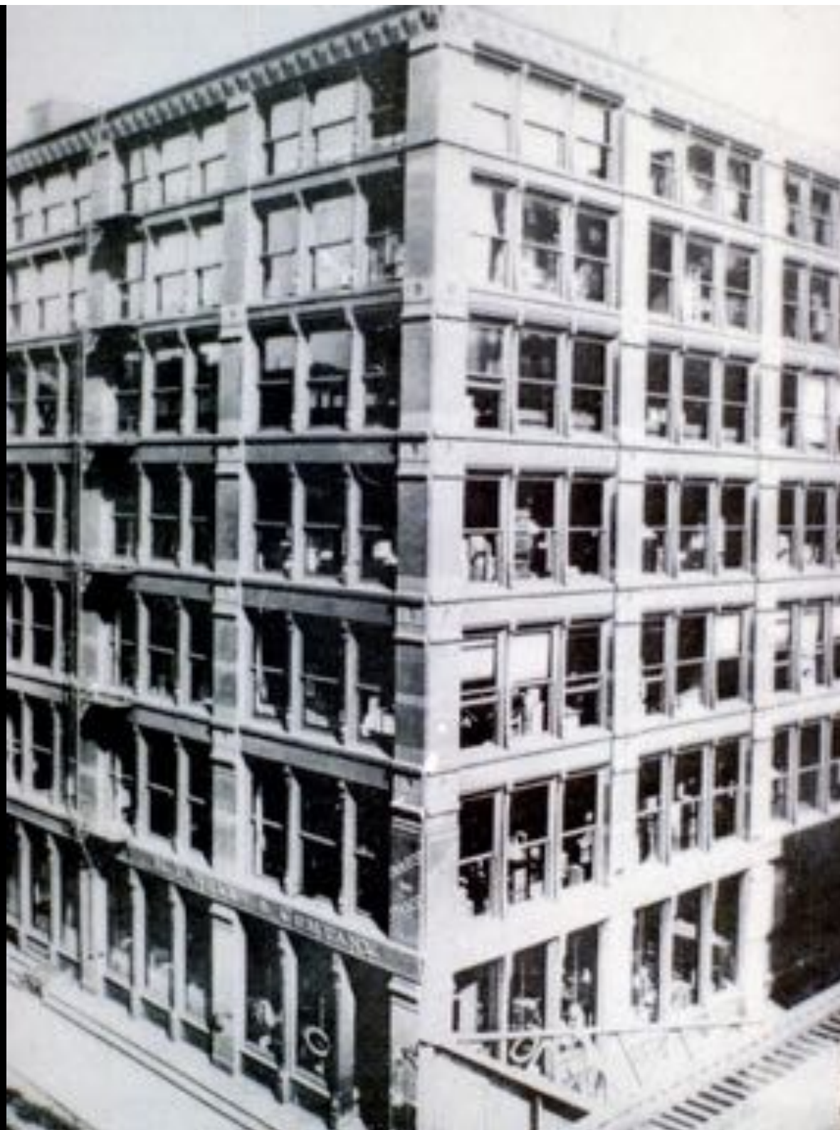
Jenney 1879 Leiter Bldg.
